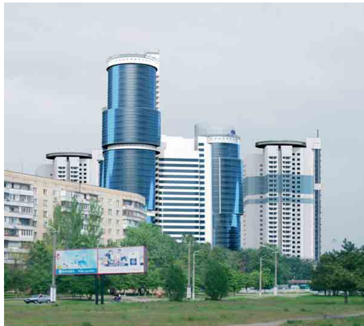
1. Житловий комплекс по набережній Перемоги (м. Дніпропетровськ)
