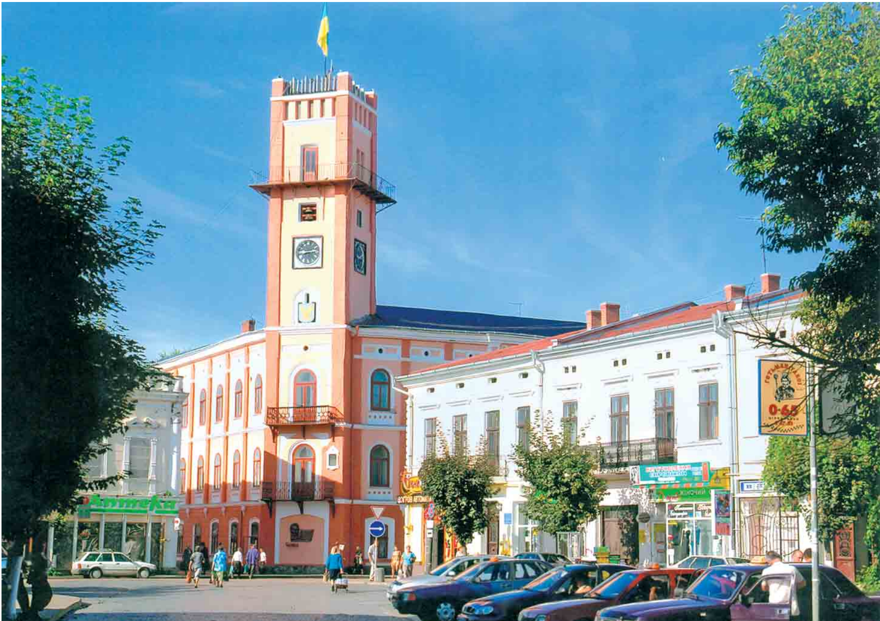
Програма ремонтно-реставраційних робіт комплексного благоустрою історичного центру м. Коломия, 2000 рік. Вид на міську ратушу (М. Ходан – керівник авторського колективу по реконструкції м. Коломия)
