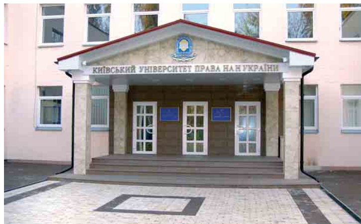
Реконструкція центрального входу та ремонт приміщень Київського університету права НАН України
