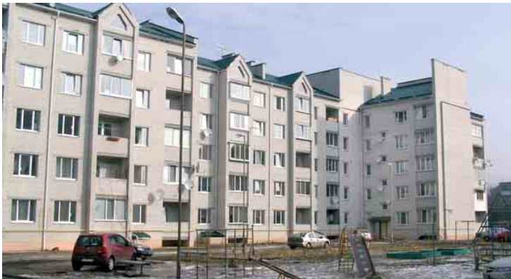
Будівництво житлового 5-поверхового будинку в с. Чубинське Бориспільського р-ну (2004 р.)
