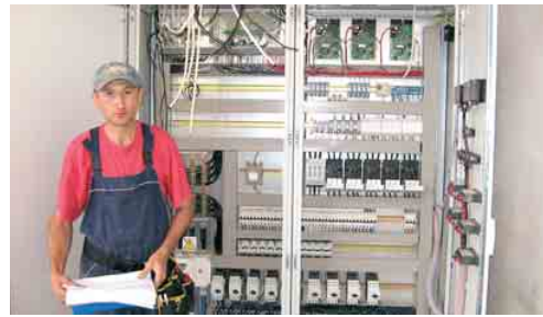
Монтаж щита управління
