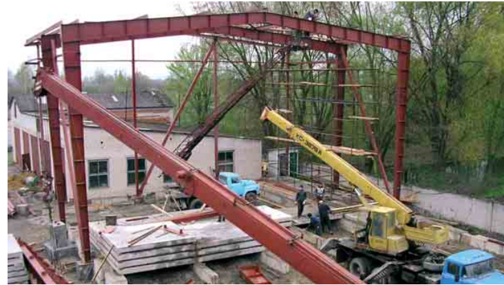
Будівництво холодильника на 1000 тонн
