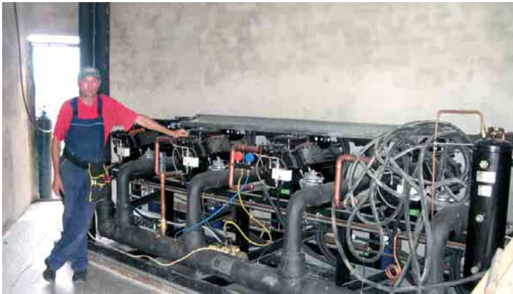
Багатокомпресорна станція фірми «Area Traders»
