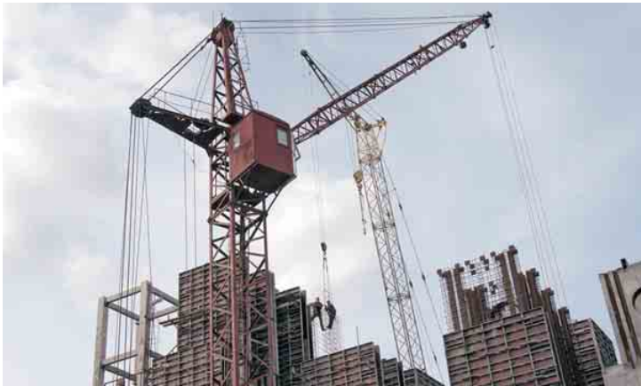
Будівельний промайданчик на об'єкті будівництва ВАТ «ІНГЗК»
