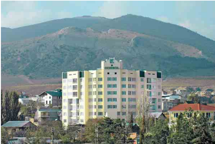
Будинок по вул. Леніна, 96 (м. Судак)
