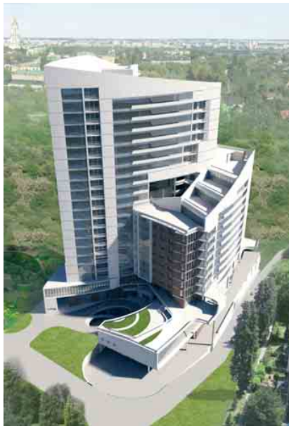
Житловий комплекс на вул. Лейпцизькій, 13
