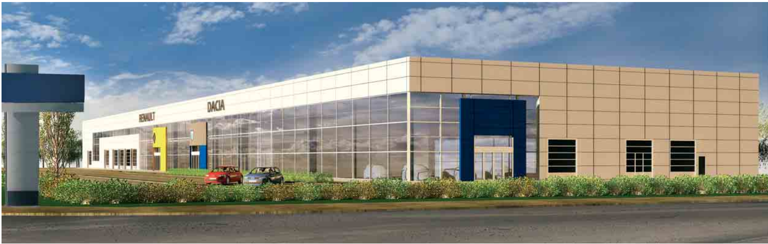
Автоцентр по вул. В. Кільцева
